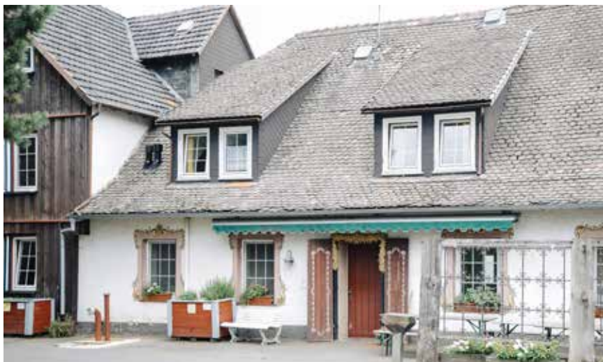
Der sanierungsbedürftige Altbau des Georgenhammers in Laubach-Lauter
