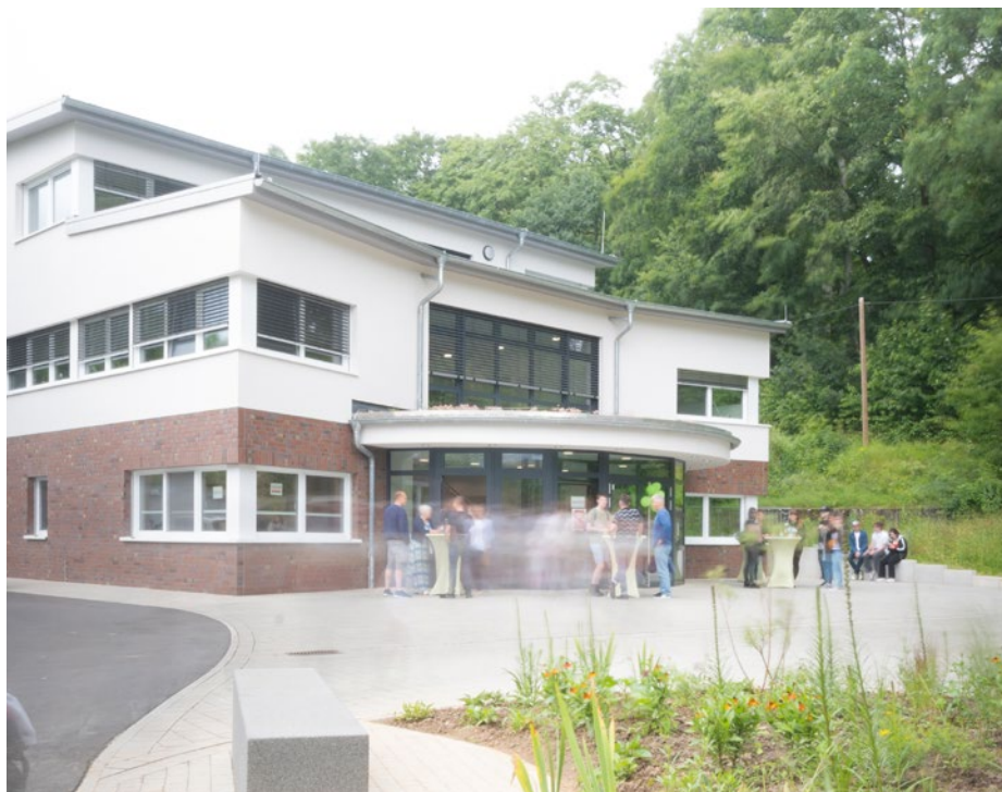
Im neuen Haus 2 sind Verwaltungsräume und die Wohngruppe 26 untergebracht.
