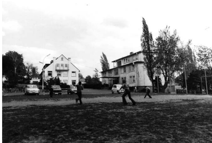
Neubau des Mädchenheims und Blick in ein Doppelzimmer, 1959, sowie Außenansicht Mitte der 1970er Jahre (Gebäude im Bild rechts, noch ohne den Anbau für Verwaltung und Großküche). Archiv Vfj
