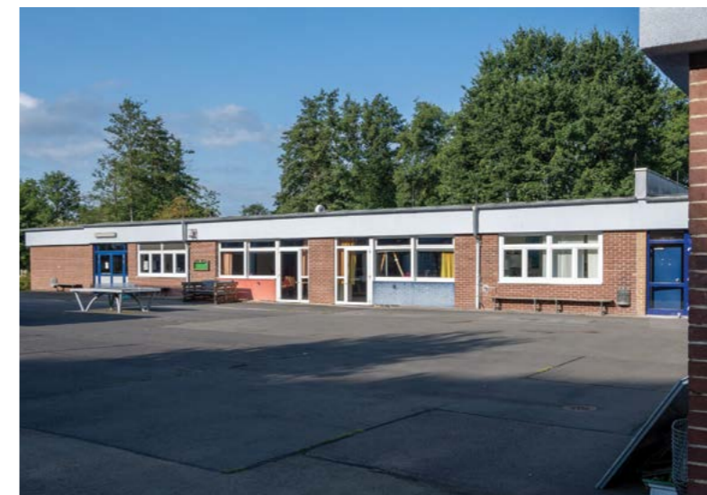
Auf der Leppermühle zwischen 1971 und 1977 errichtetes Schulgebäude mit Klassenraum und Sporthalle (linke Seite). Archiv Vfj
